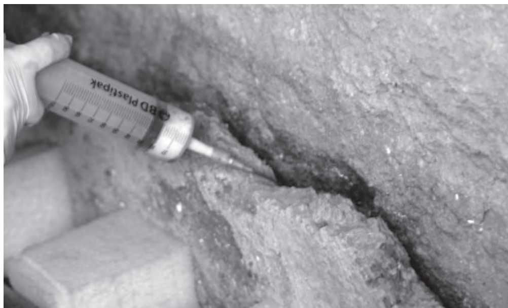
Figura 16. Inyección de consolidante.
