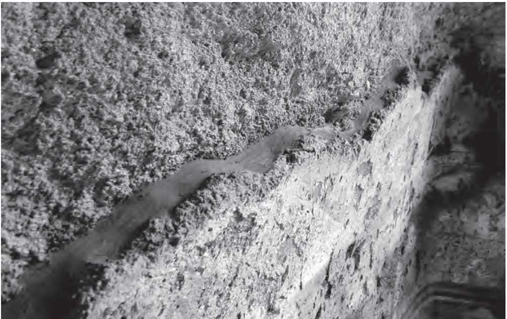
Figura 18. Sellado de la junta con mortero de cal y arena.
