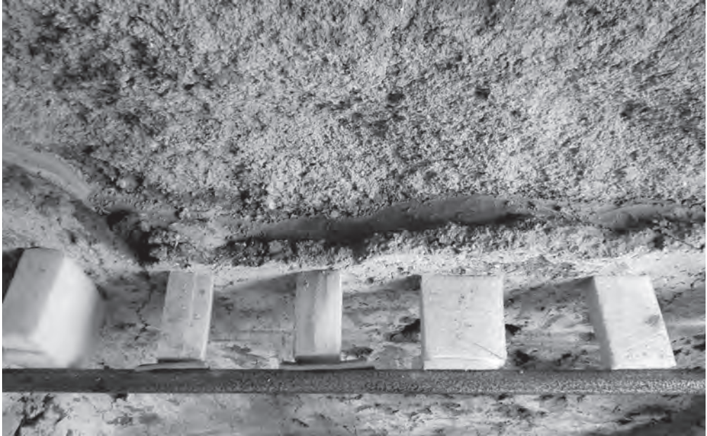
Figura 17. Relleno con mortero sintético.
