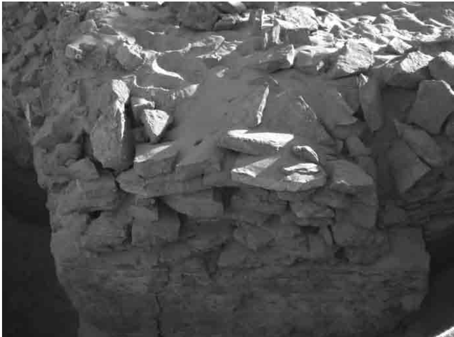
Figura 2. Mampuesto perimetral sobre plataforma.
